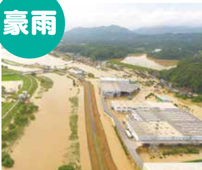
令和元年 8月28日佐賀県大町町 (画像提供:国土交通省九州地方整備局)
