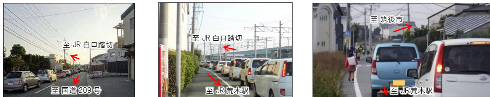
写真①現道の渋滞(国道209号→JR白口踏切) 写真②現道の渋滞(JR荒木駅→JR白口踏切) 写真③歩道未設置区間の通学状況(荒木小学校)
