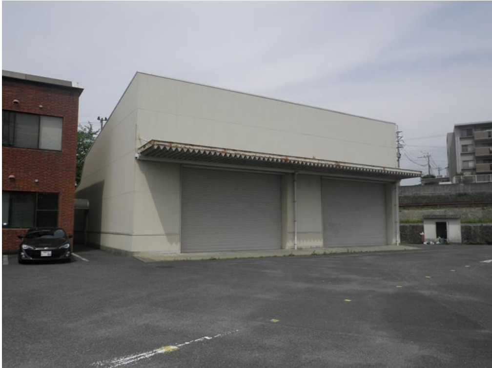
全景（検査棟A）
