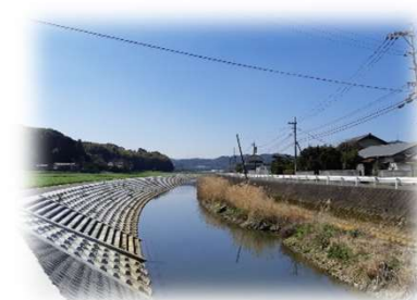
<河川の護岸工事>
