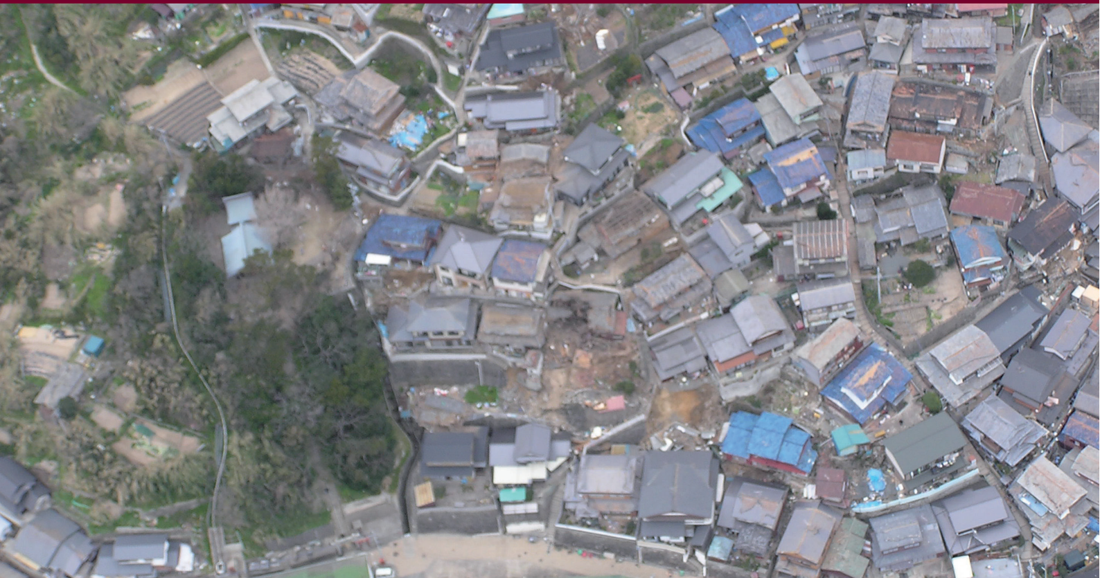
平成17年3月福岡県西方沖地震直後の玄界島
