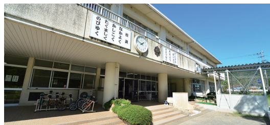
益城町立飯野小学校校舎
