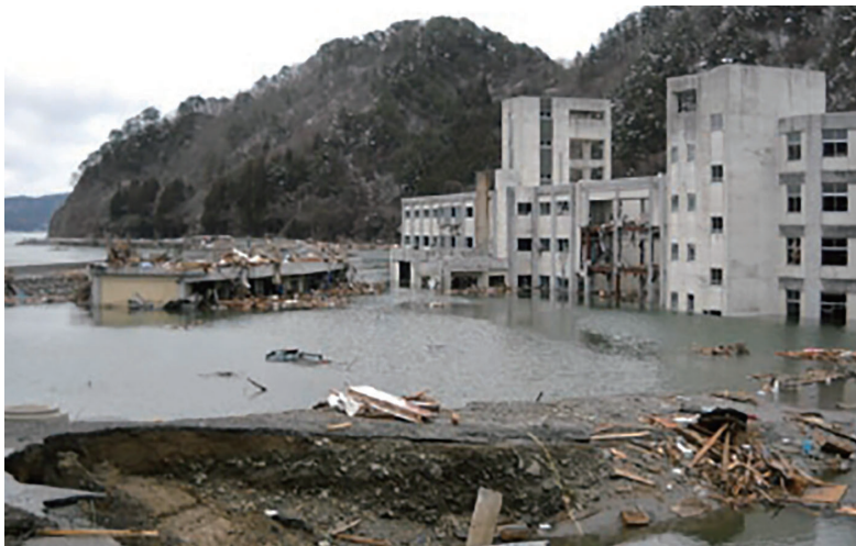
平成23年4月水が引いた後の釜石東中学校
