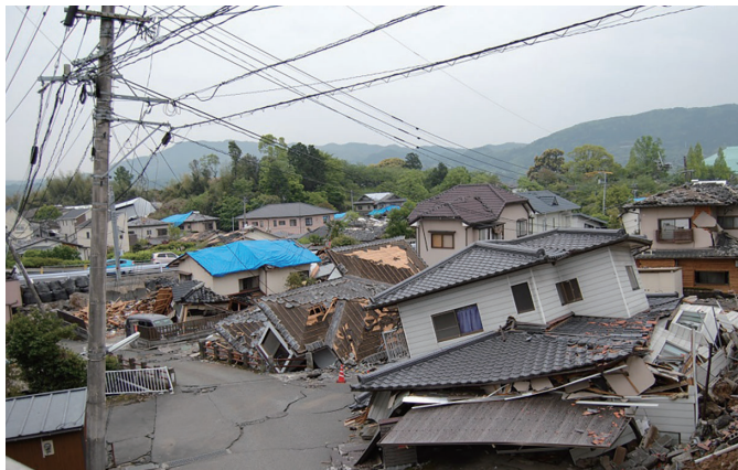
平成28年6月熊本県益城町 (画像提供:九州地方整備局)
