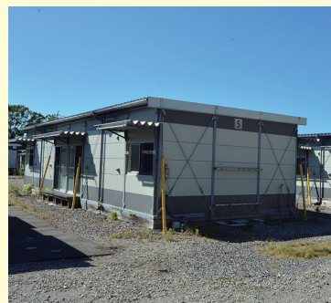
運動場に建てられた仮設住宅
