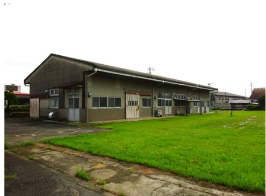
No. 4 い草栽培作業棟
