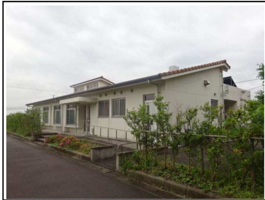
柳 寮 (第2工区児童寮A棟)
