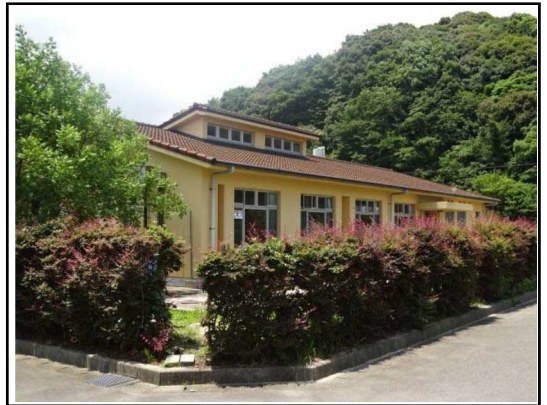
梅寮（第1工区児童寮C棟）
