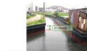
用水路の事前水位低下による雨水貯留 (吉井川水系、岡山市)
