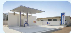
水素ステーション
