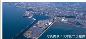
三池港 三池炭鉱で産出された石炭を運び出すためにつられ、現在も産業港として使われている
