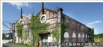
遠賀川水源ポンプ室 1910年以来、現在も動き続けている製鐵所の送水施設
