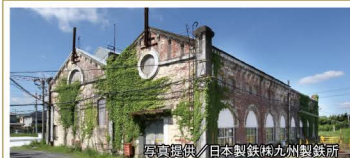
遠賀川水源ポンプ室 1910年以来、現在も動き続けている製鐵所の送水施設
