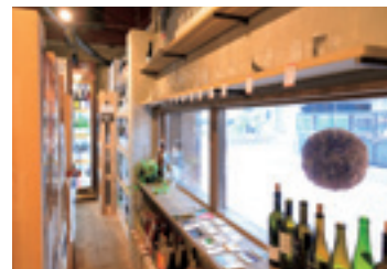
▲ ガラス窓にはUVカットフィルムを採用。
