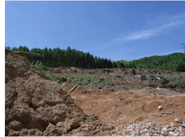
住宅地造成のための森林伐採
