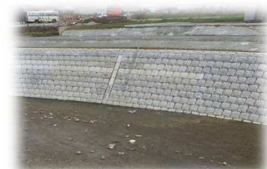
<河川の護岸整備>
