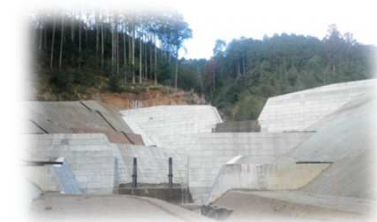
<災害復旧の状況(砂防施設)>
