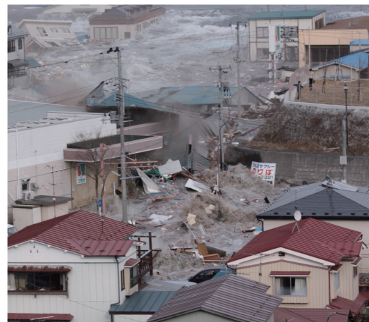
平成23年3月11日東北地方太平洋沖地しん、岩手県山田町 (画像提供: 東北地方整備局 震災記録)
