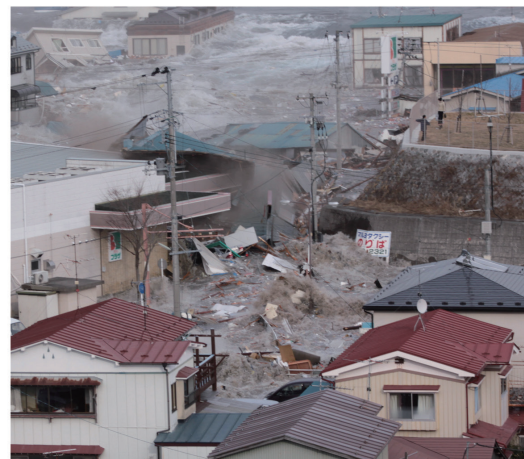
平成23年3月11日東北地方太平洋沖地しん、岩手県山田町 （画像提供：東北地方整備局 震災記録部）
