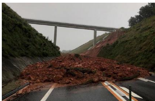
東九州自動車道【暫定2車線区間】
