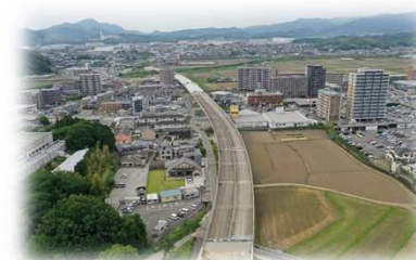
<筑紫野古賀線(バイパス整備)>
