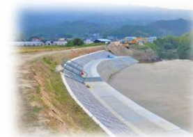
<河川の護岸工事>
