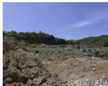
住宅地造成のための森林伐採
