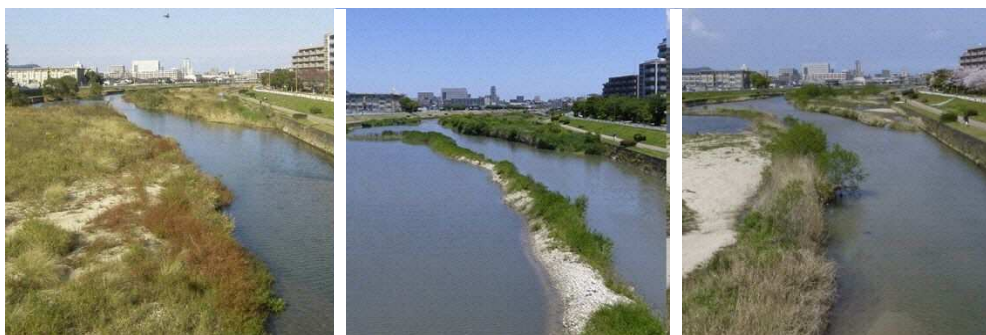
水際を保全した浚渫の例(室見川:左から浚渫前、浚渫直後、浚渫から2年後)
