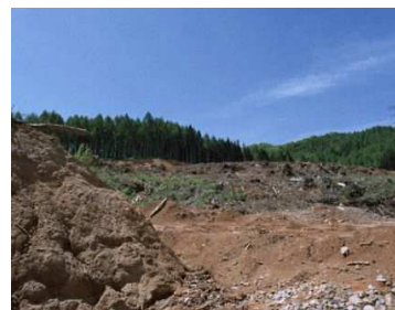
住宅地造成のための森林伐採
