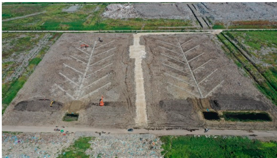
福岡方式による廃棄物処分場の整備(ヤンゴン)
