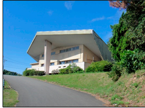
志賀島ビジターセンター(福岡市)
