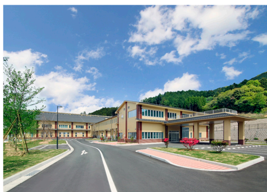
田川地区クリーンセンター
