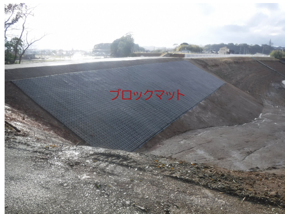
池上池 堤体改修写真
