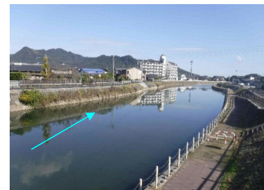
長音寺橋より下流の状況(護岸整備後)
