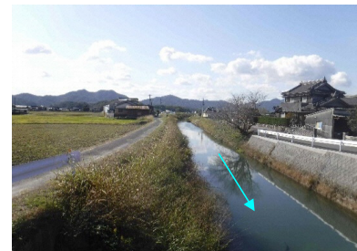
水正橋より上流の状況(現況河道)
