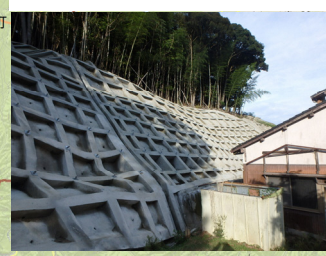
【急傾斜地対策イメージ写真】
