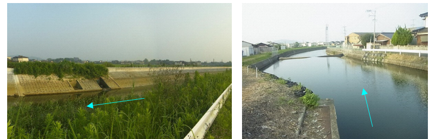
江尻川橋より下流の状況(1k200付近高潮堤防工事後) 蔵丸橋より下流の状況(護岸工事後)
