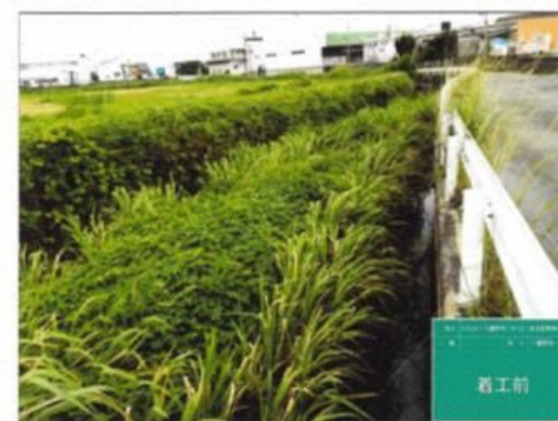
手鎌野間川の 浚渫状況
