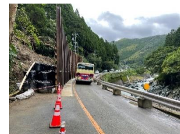
応急復旧状況(通行止解除)
