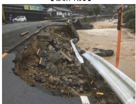
■道路の復旧（一般国道 211 号） 【復旧前】
