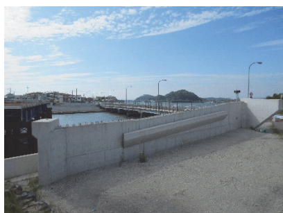
■図表-139 橋梁の架換え (主要地方道直方芦屋線)
