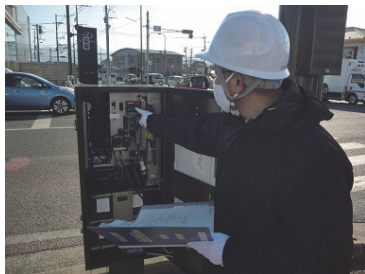
■図表-141 信号機電源付加装置の更新
