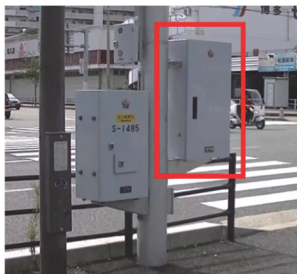
■図表-141 信号機電源付加装置の更新
