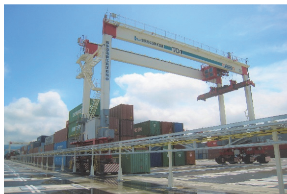
■図表-70 電動トランスファークレーン（博多港）
