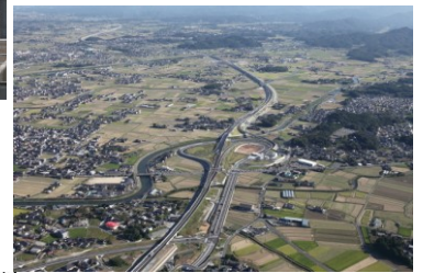
東九州自動車道
