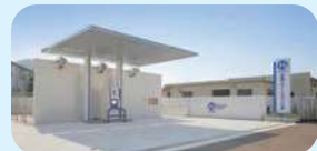
水素ステーション
