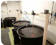
(タイラギ種苗生産施設)
