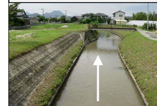
①河道の拡幅・護岸改修
