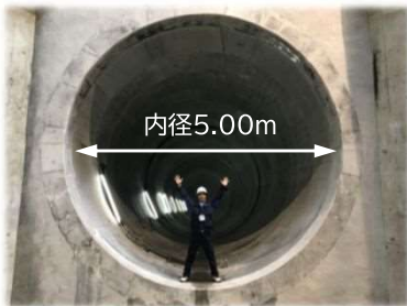
中部2号幹線最下流部
