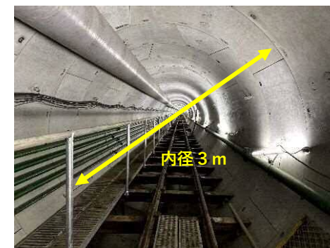
施工状況(シールド工法)
