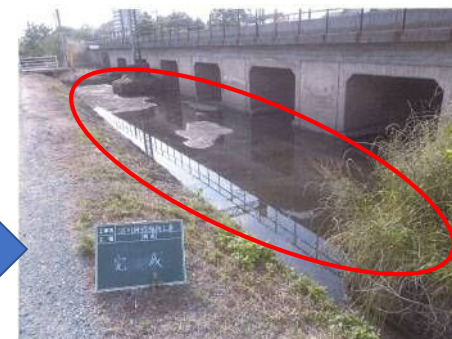
伐採・浚渫後①
