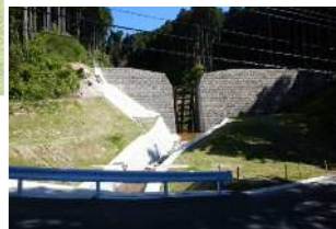
【砂防堰堤イメージ写真】
