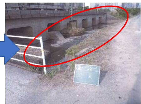
伐採・浚渫後②
