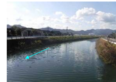
銀杏の木橋より上流の状況(現況河道)
