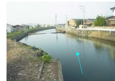
蔵丸橋より下流の状況(護岸工事後)
