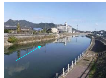
長音寺橋より下流の状況(護岸整備後)
