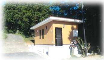
キャンプ場のトイレ整備
