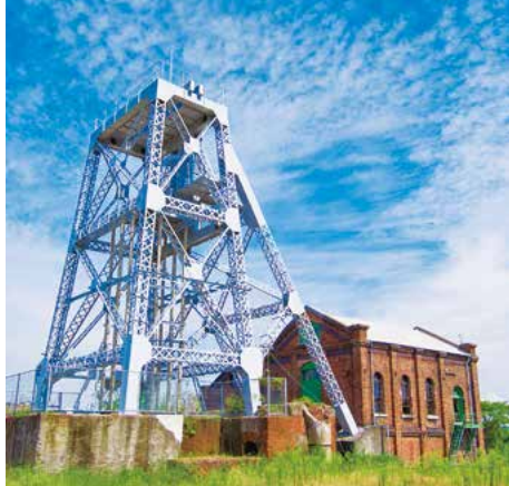
万田坑 竖坑関係施設が良好な状態で保存されている 【所在地】熊本県荒尾市原万田200-2 【連絡先】0968-63-1274(荒尾市文化企画課)
