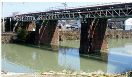
専用鉄道敷跡 三池炭鉱と三池港を結ぶ大動脈 【所在地】福岡県大牟田市内、熊本県荒尾市内 【連絡先】0944-41-2515(大牟田市世界遺産・文化財室)、 0968-63-1274(荒尾市文化企画課)
