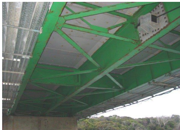
図2 2008/10 (施工前, 前回塗替え2年経過)
