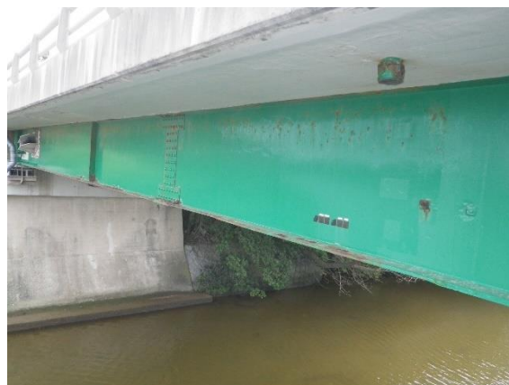
図-4 汐入川橋 ワッペン試験片
