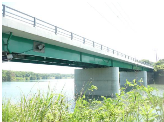
図-3 汐入川橋 全景
