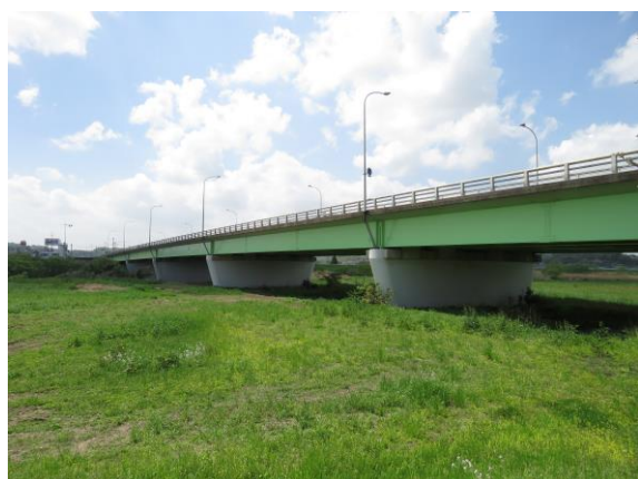
図-7 直方大橋 全景
