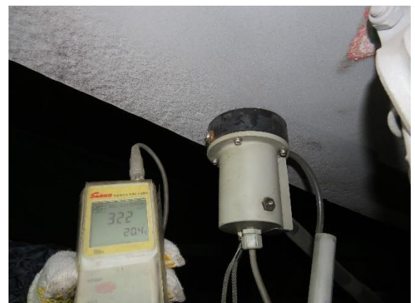
図4 2014/10/14 (施工中の品質管理)
