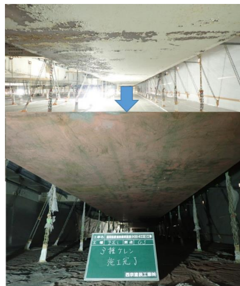
写真-3 塗膜剥離部の素地調整（3種ケレン）
