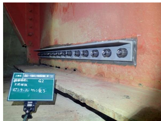
写真-3 補強対策
