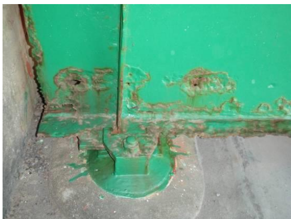
図3 2008/10 (施工前, 前回塗替え2年経過)
