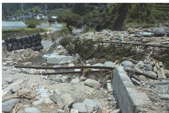
筑前岩屋駅付近（土砂流入）
