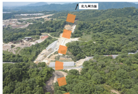
■図表-83 高規格道路を補完する道路の整備 (一般国道 322 号嘉麻バイパス)
