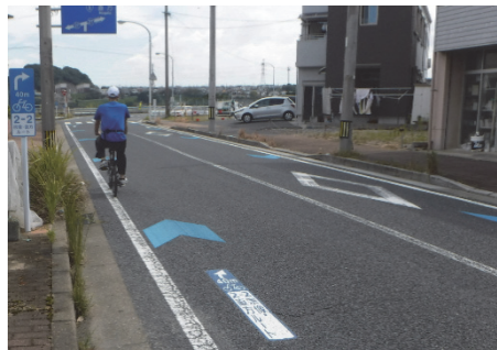
■図表-115 自転車の案内看板・路面表示 (一般県道 高浜東町線)
