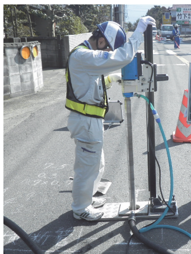
■図表-137 路面下空洞調査
