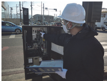
■図表-141 信号機電源付加装置の更新
