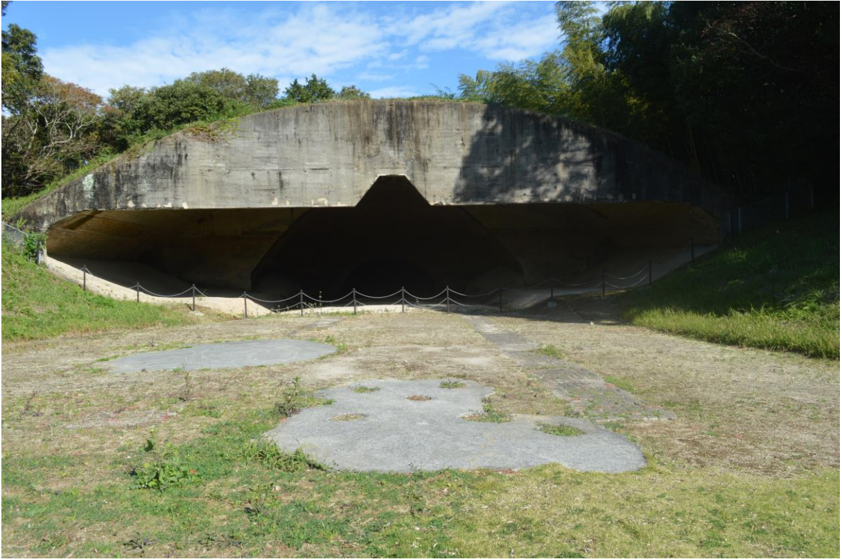
海軍築城航空基地稲童掩体外観
