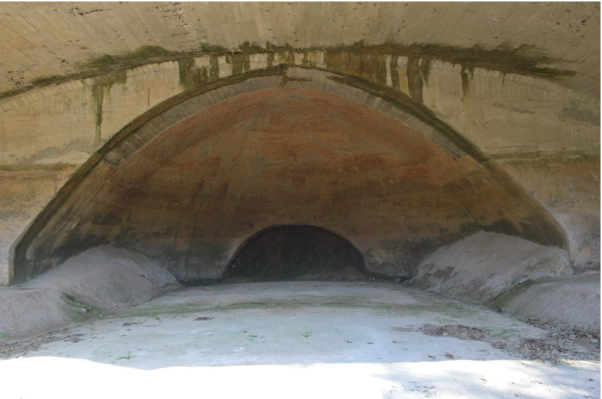
海軍築城航空基地稲童掩体内部
