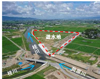
河川整備、遊水地整備
