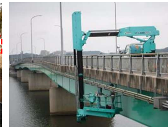
橋梁定期点検
