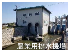
農業用排水機場
