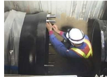
共用水道管の布設
