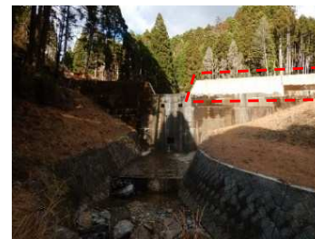
砂防堰堤修繕
