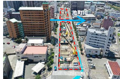
池町川(地下調節池)
