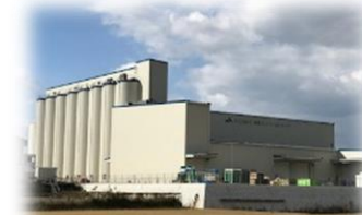
<カントリーエレベーター>
