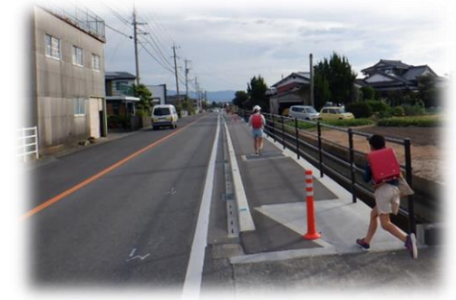
<通学路の歩道整備>
