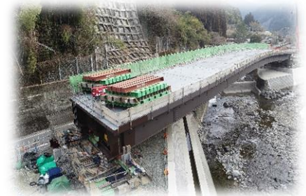
<橋りょうの架替>
