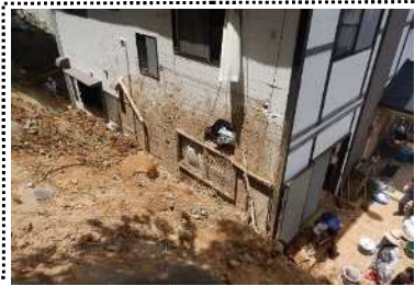
【災害関連緊急急傾斜地崩壊対策事業】 福岡市西区愛宕(愛宕地区)
