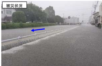
池町川(浸水) 久留米市
