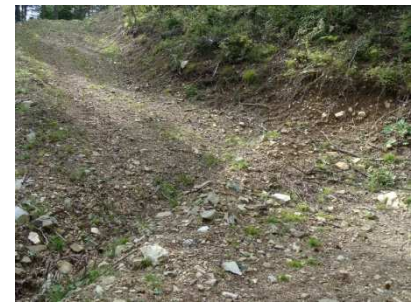
素掘りによる横断溝
