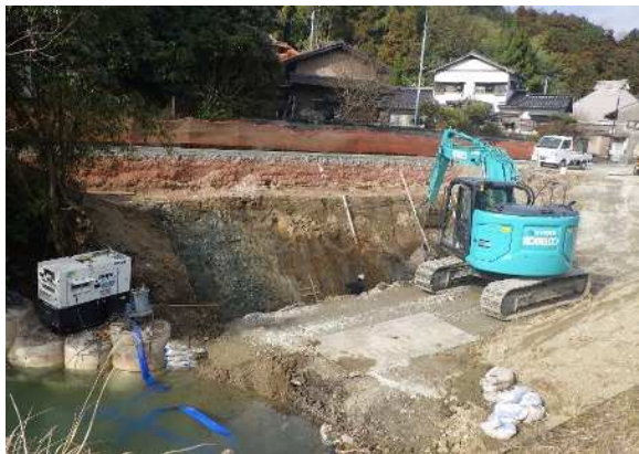
復旧工事 施工中
