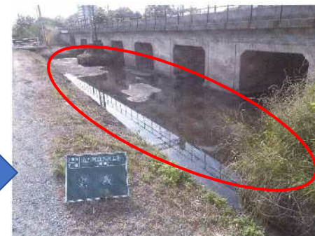
伐採・浚渫後①
