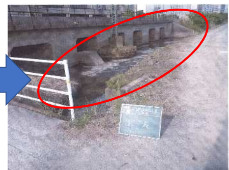
伐採・浚渫後②
