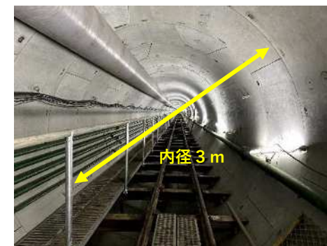
施工状況(シールド工法)
