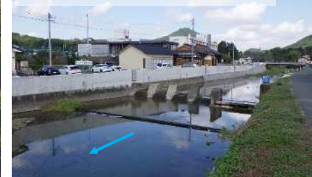
【浸水対策工 (南関町関町地内)】
