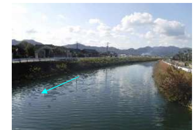
銀杏の木橋より上流の状況(現況河道)
