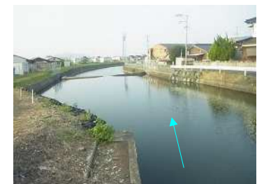
蔵丸橋より下流の状況(護岸工事後)
