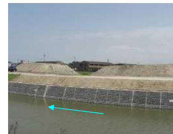
須賀里橋より上流の状況(護岸整備後)
