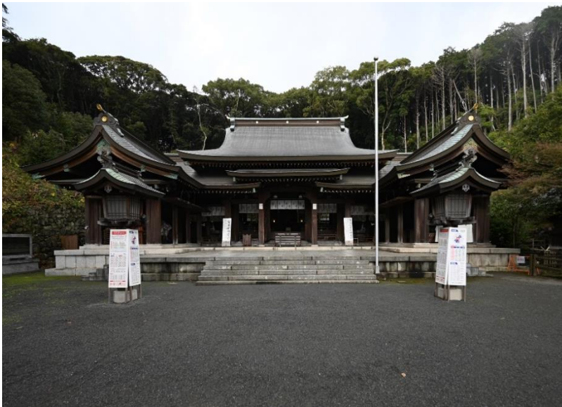
写真1 拝殿・渡廊・祭舎 (南から)
